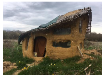
La cabane du puits, à l'Est de la ZAD, détruite par les gendarmes (JL)
